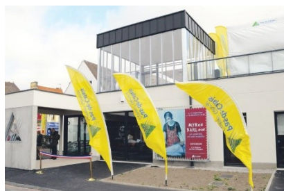
Maison du Port Départemental d'Étaples
