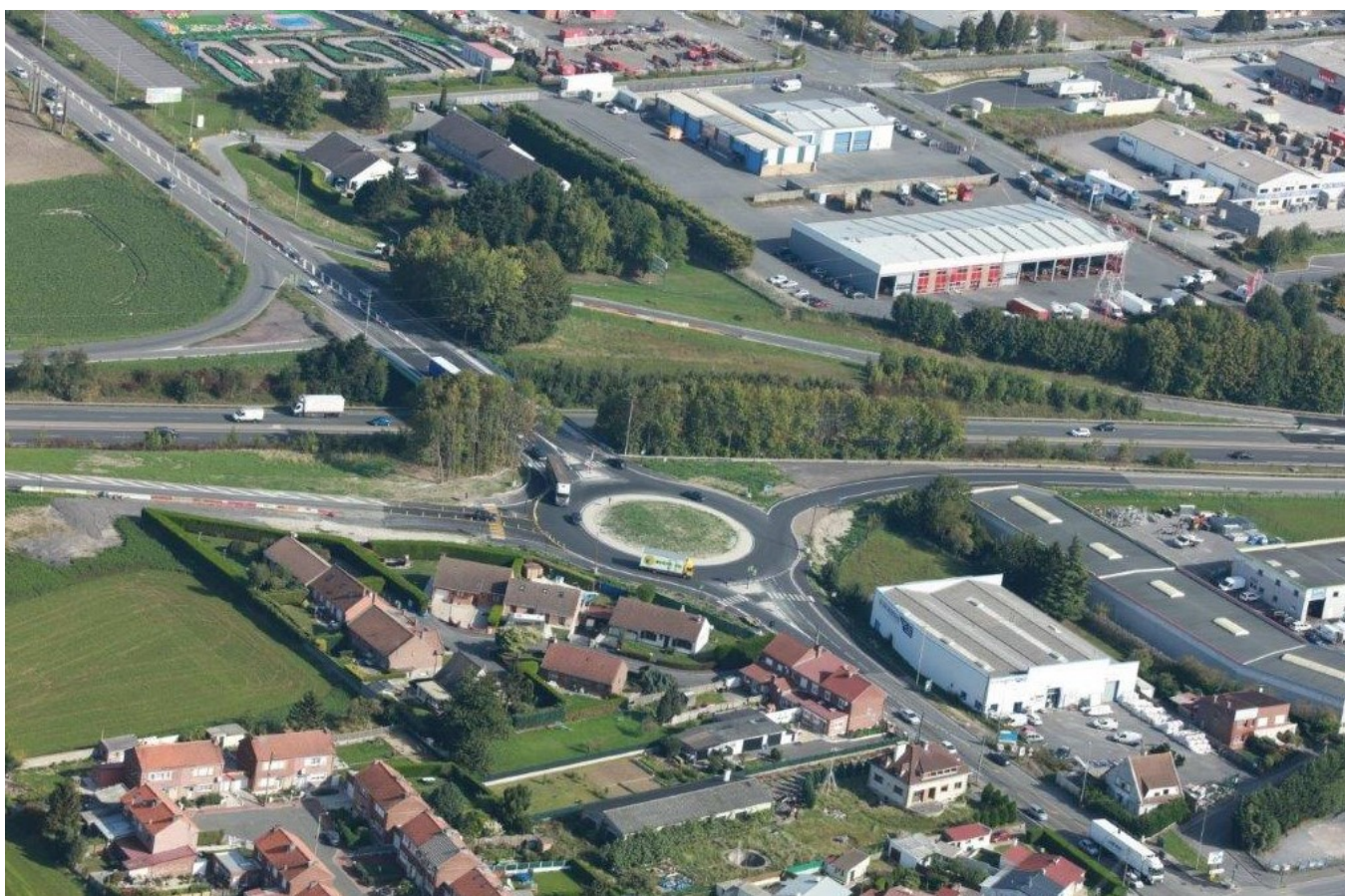
Accessibilité du nouvel hôpital de Lens
