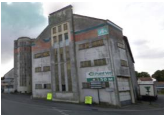
Silo à céréales d'Achiet-le-Grand
