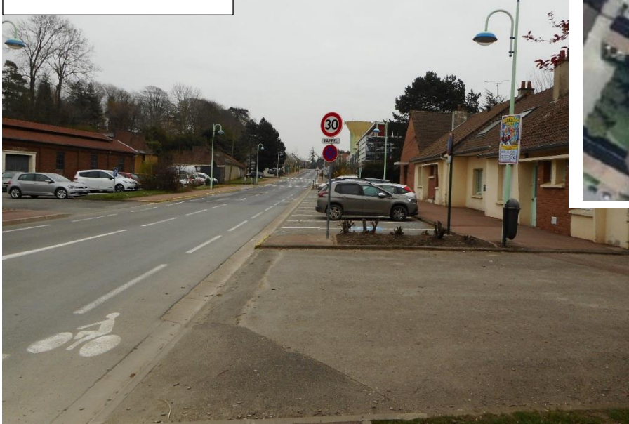
AVENUE Charles de Gaulle avant travaux
