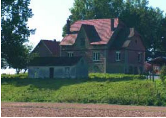
Ferme de l'Abbaye d'Eaucourt, sur le sentier de l'Abbaye d'Eaucourt
