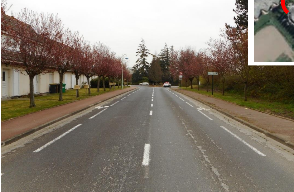
Avenue Charles de Gaulle avant travaux
