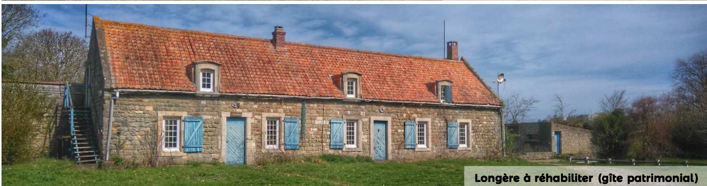
Maisonnette à réhabiliter (logement Eden)
